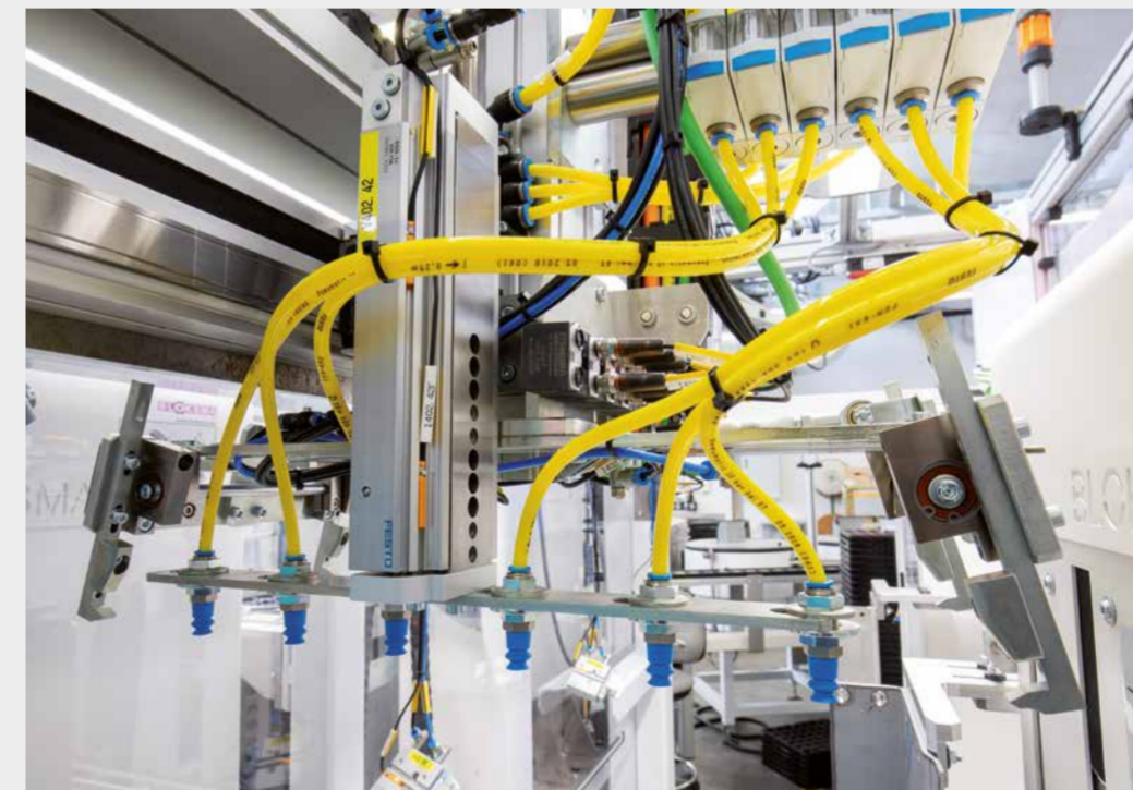
Die Module werden direkt neben der Sensorik und Aktorik – mithin am Prozess – angebracht, zum Beispiel auf pneumatisch betriebenen Einheiten oder auf Greifern.
