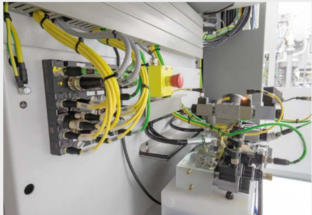
Die kompakten Cube67-Module sind in unmittelbarer Prozessnähe angebracht, ...
