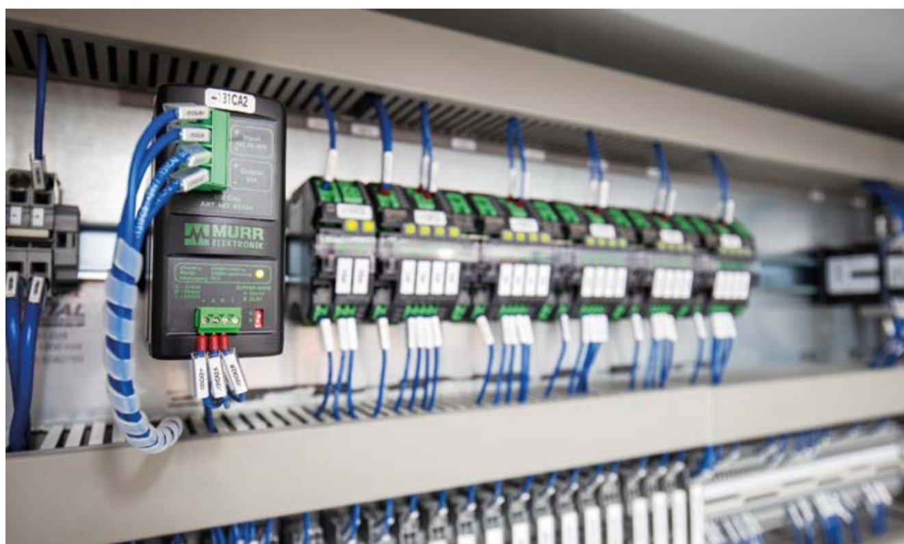
Blick in den Schaltschrank mit Emparro Netzgerät
