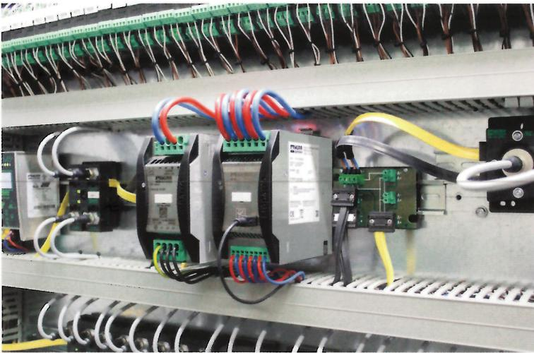
Das USV-Modul sorgt verlässlich für eine unterbrechungsfreie Stromversorgung.
