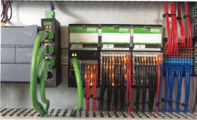
Der Einsatz von Cube20 ist eine kostengünstige Lösung, denn statt vieler einzelner E/A-Karten müssen nur wenige Module auf der Hutschiene montiert werden.
