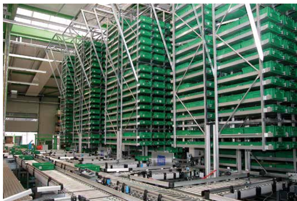
Das hochmoderne Logistik-Center
